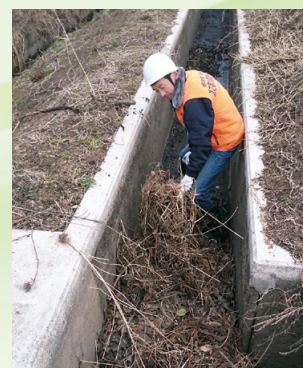
用水路泥上げ作業 (多面的機能支払交付金)
