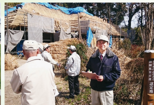
国指定重要文化財 入野家住宅薬葺き屋根改修工事 (事務調査)
